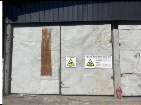
危险废物暂存间
