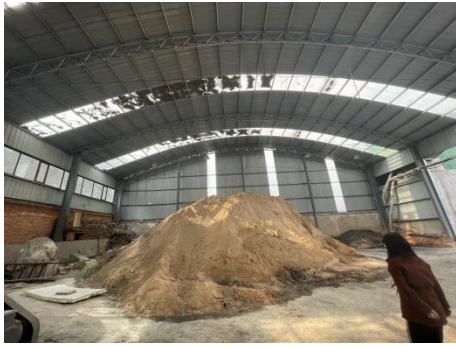
项目原料堆棚内部
